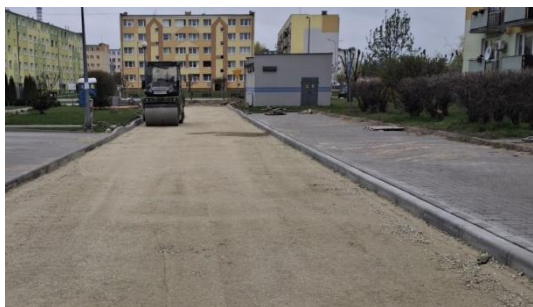
Zdjęcie 1. Remont ul. Piastowskiej.
