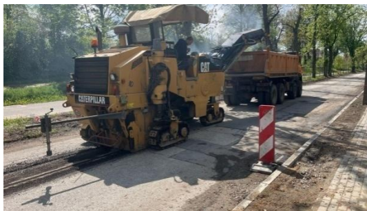
Zdjęcie 6. Remont ul. Dworcowej.
