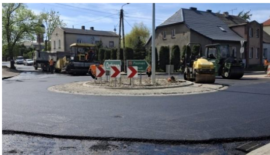
Zdjęcie 4. Remont ul. Wyszyńskiego - rondo
