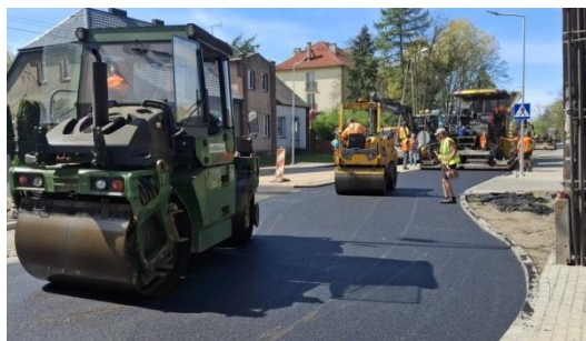
Zdjęcie 2. Remont ul. Wyszyńskiego.
