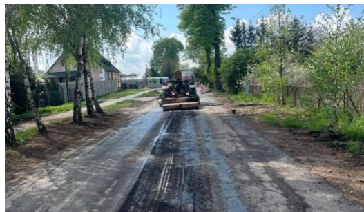
Zdjęcie 5. Przebudowa ulic: Prusa, Kopernika, Przemysłowej
