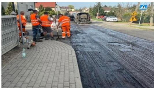
Zdjęcie 8. Przebudowa ulic: Prusa, Kopernika, Przemysłowej
