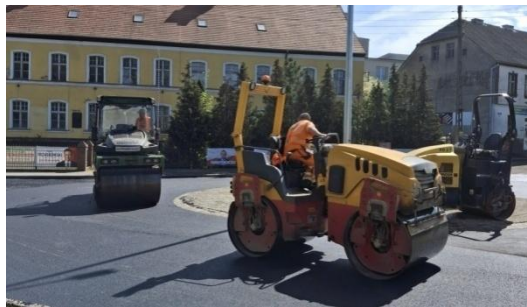
Zdjęcie 3. Remont ul. Wyszyńskiego - rondo
